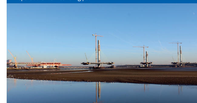
Puente de Mersey. Reino Unido.
