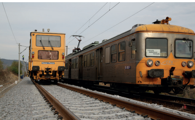
Tramo ferrocarril Atel-Micasasa y Sighisoara-Atel.
