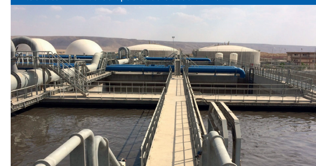
Depuradora New Cairo. Egipto.
