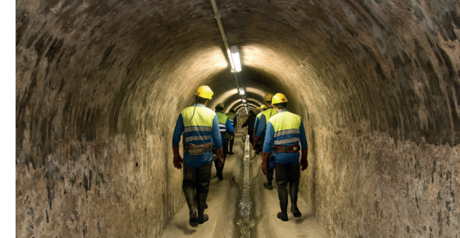
Red de alcantarillado de Barcelona. España.
