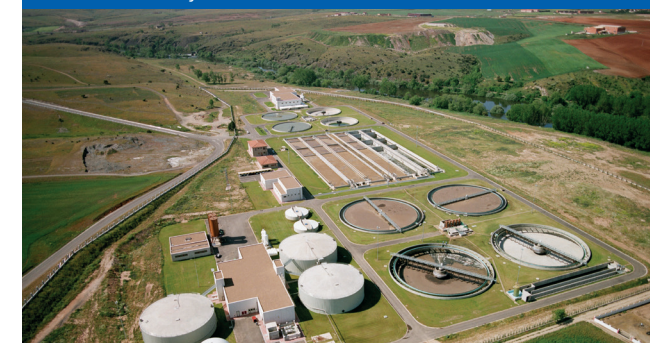
Estación depuradora de aguas residuales de Salamanca. España.
